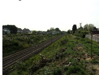
talud vlak voor brug Elzenstraat
