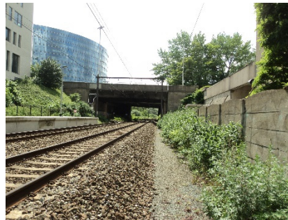
brug Zelliksesteenweg, kant Brussel
