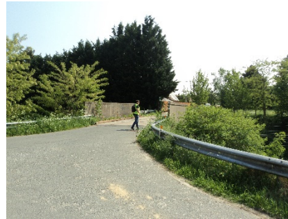
Brug over de sporen, Tenbroekstraat
