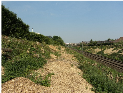
talud na de brug Elzenstraat
