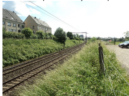
zone tussen Veroost en spoor
