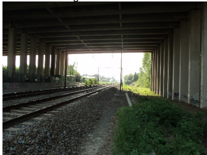
viaduct R0, brug E19
