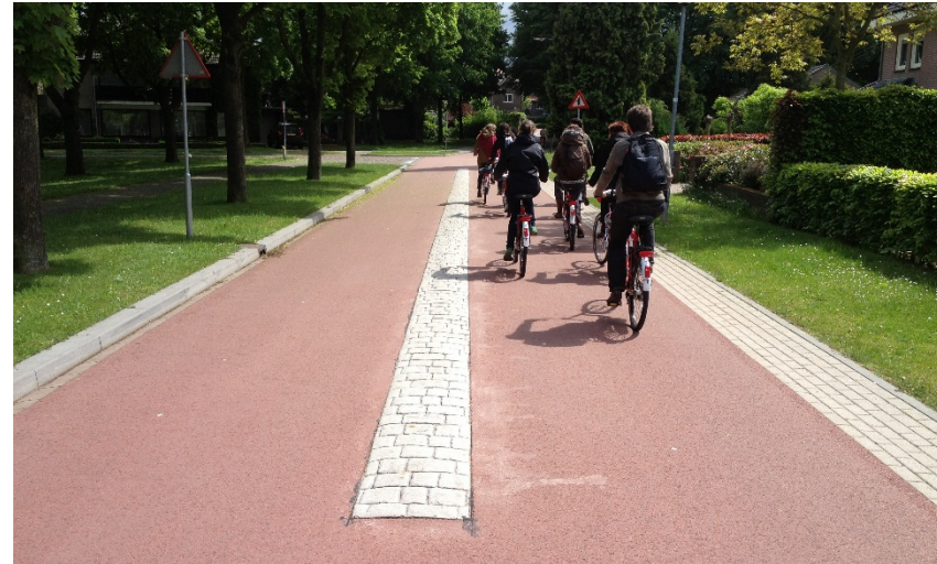
Figuur 13 straatprofiel met verhoogde middengeleider
