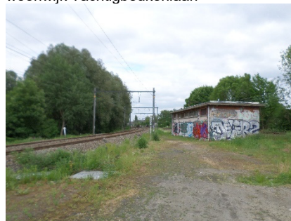
locatie samenkost spoorlijn 50 en 60
