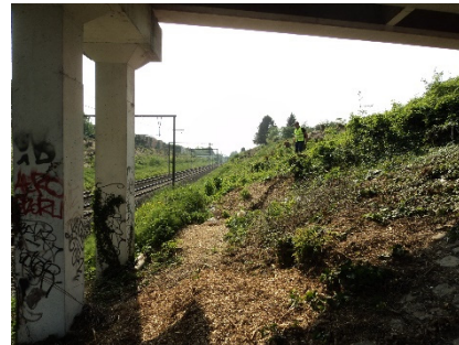
situatie onder de brug Elzenstraat
